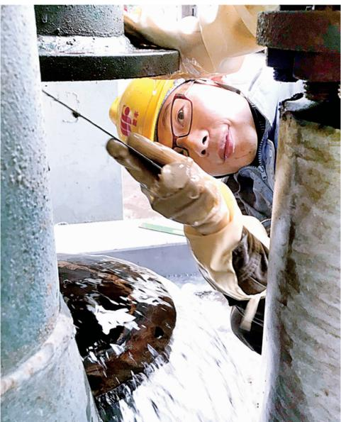
左图:切割三期尿素装置汽提塔气相管法兰螺栓。
