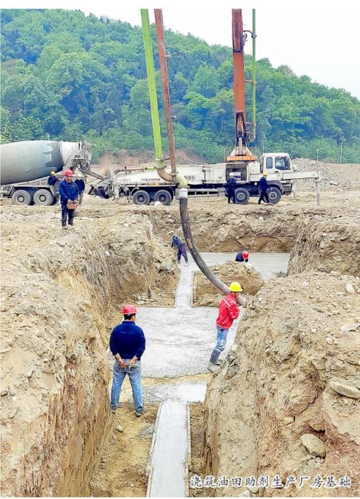
浇筑油田助剂生产厂房基础
