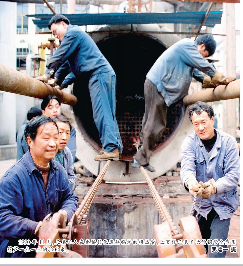
1990年11月,几名工人在更换转化废热锅炉的换热管,上百根三米多长的钢管全靠用葫芦一点点的拉出来。
