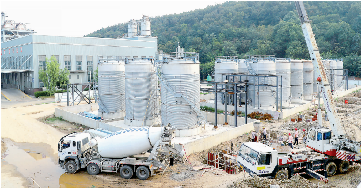
▲ 科技公司技改项目建设现场。(唐有 摄)
