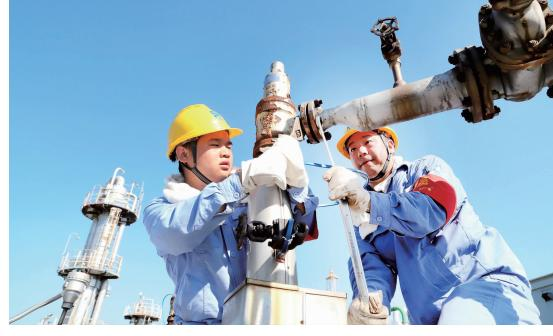
▲ 阳中双瑞大修现场，党员先锋队陈印山带领徒弟张志威检修 V202 脱水塔安全阀。
