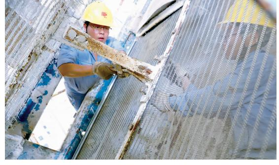
▲ 复合肥一体化大修现场，检修人员张磊、刘云正在更换热筛网。
