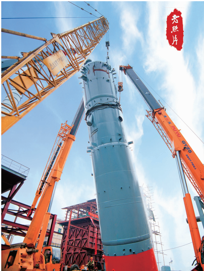
▲ 2004 年 7 月,公司德阳生产片区 2030 技改工程项目施工现场,正在吊装二段炉。 罗建一 摄
