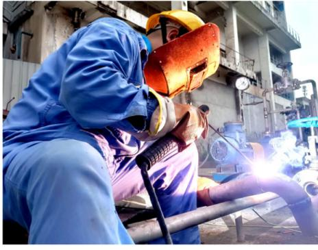
▲化肥分公司员工刘去兵焊接洗涤泵进口水管线
