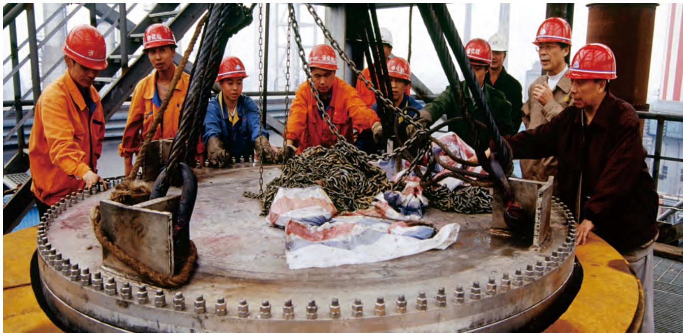
▲ 氨合成塔内件安装
