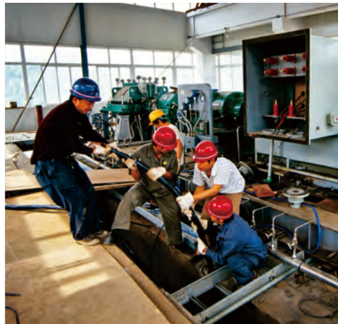
▲ 联压机厂房电缆敷设
