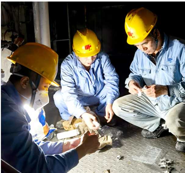
化肥分公司尿素一车间 对尿素装置造粒塔喷淋系统进行环保改造
