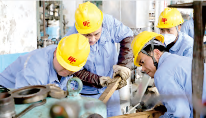
▲ 化肥分公司装置检修优化消缺
