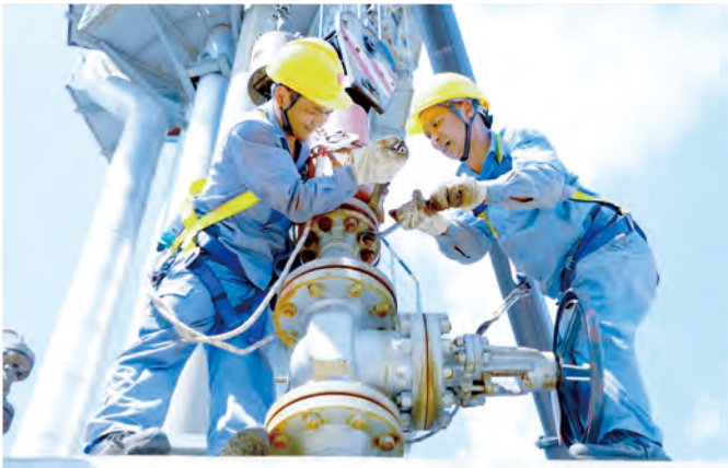
▲ 科技公司大修现场，检修人员装配安全阀。
