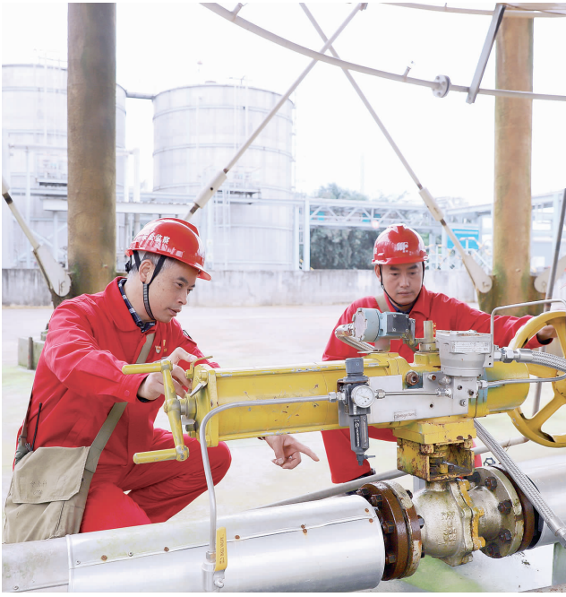
▲ 检查氮罐出口 DCS 调节阀情况
