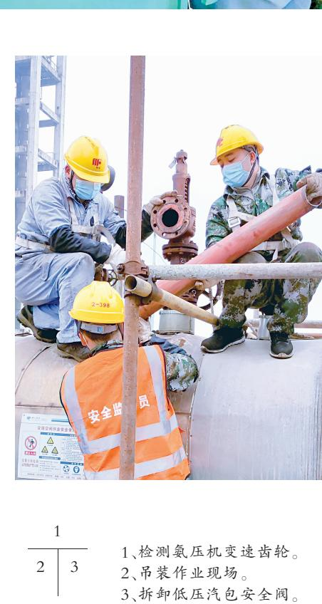
1. 检测氨压机变速齿轮。
